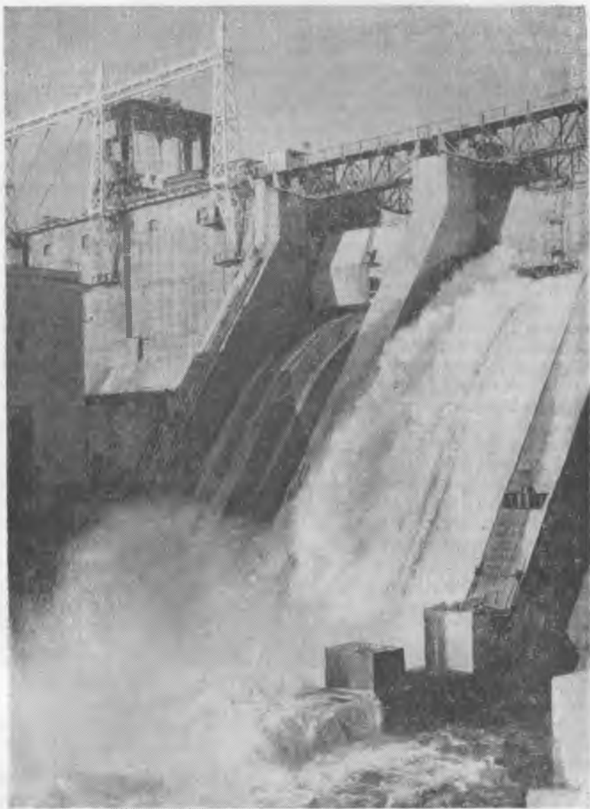
Рис. 4. Водосливная часть плотины Усть-Каменогорской ГЭС.
