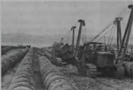
Рисунок 4 – Строительство газопровода «Средняя Азия-Центр» [8]
